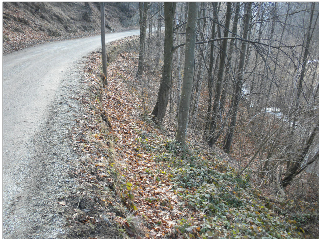
FOTO 1B: vista dalla strada del settore d'intervento da monte verso valle
