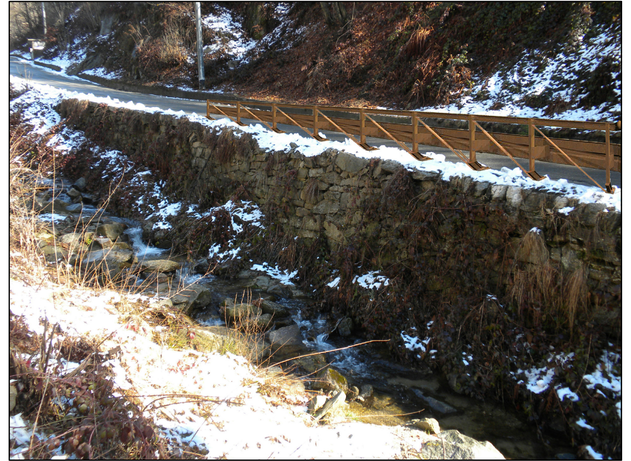
FOTO 1C: vista da valle del settore di intervento - post operam
