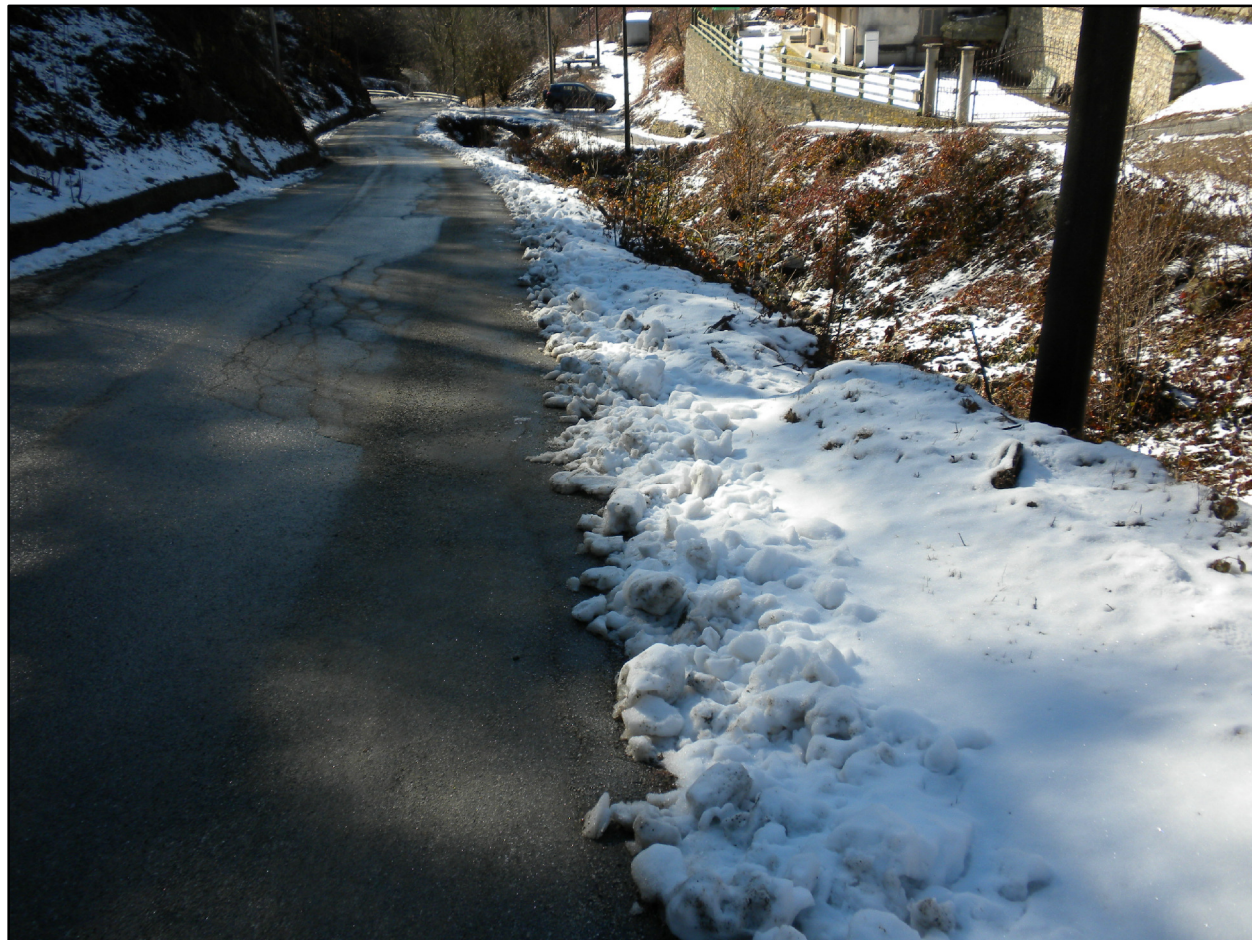
FOTO 2C: vista da monte del settore di intervento
