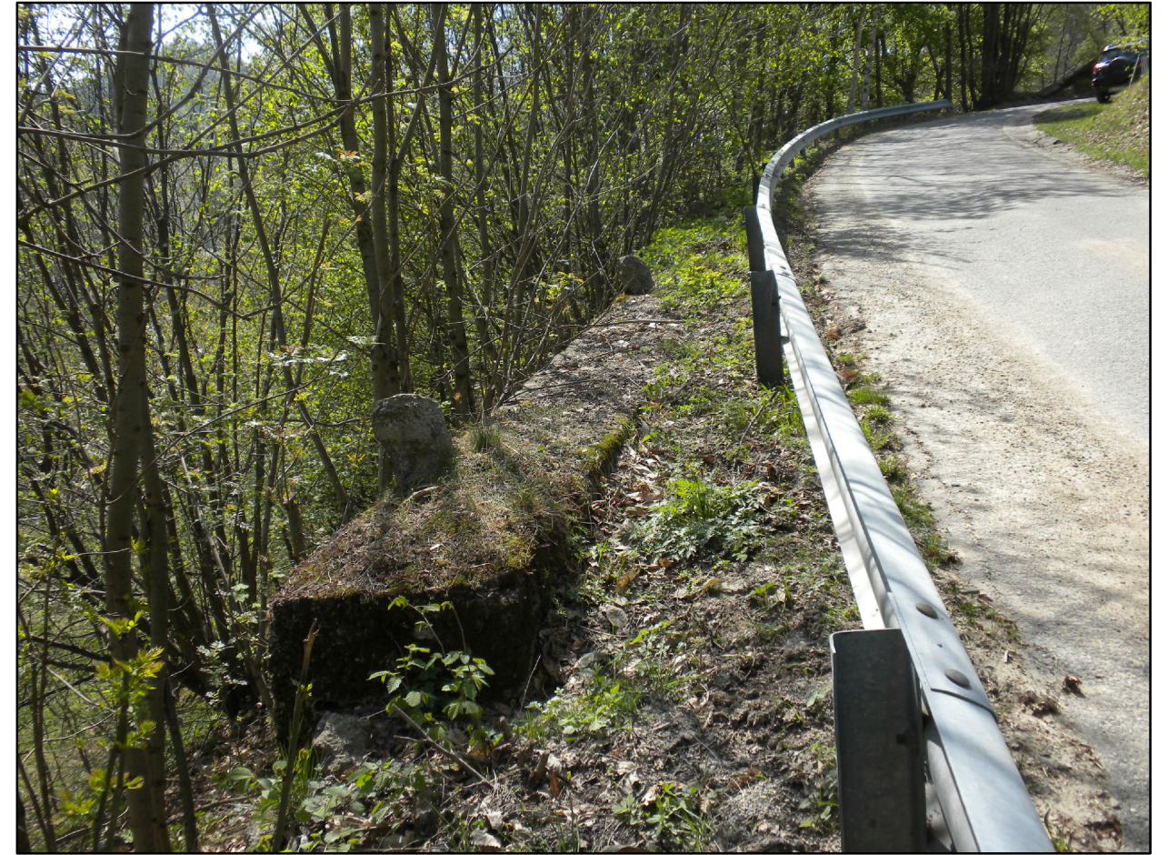
FOTO 2A: tratto di intervento mediante consolidamento con micropali
