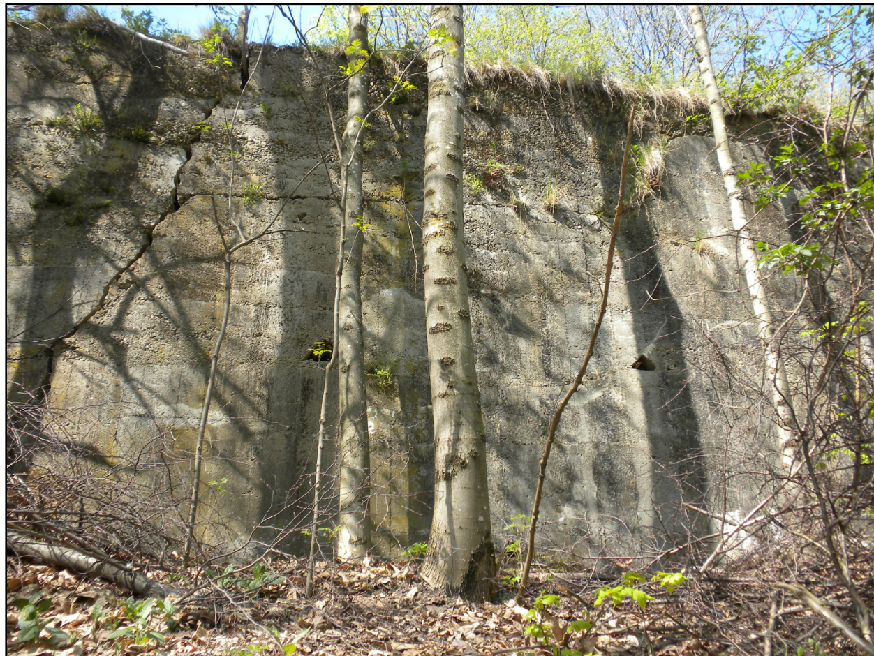
FOTO 3A: vista da valle dell'opera di sottoscarpa esistente
