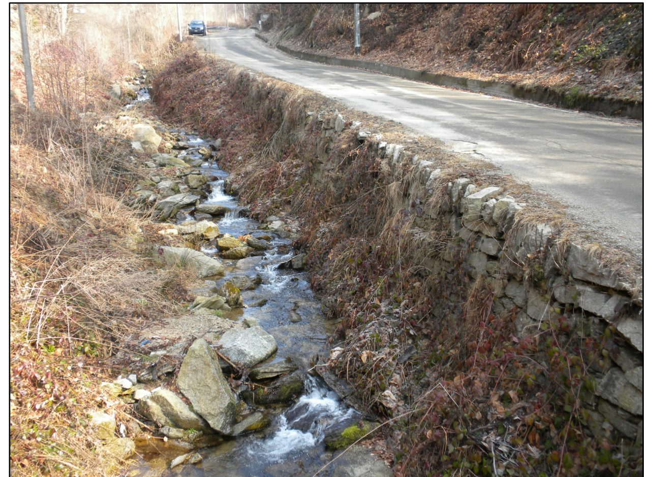
FOTO 3C: vista dal ponte verso monte del settore di intervento
